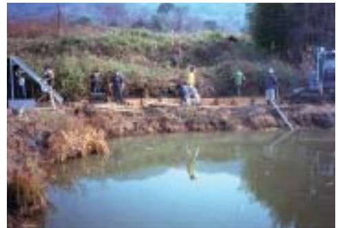
ニッポンバラタナゴの保護池における太陽電池を使用した水浄化循環システムの設置工事(2002年1月13日)
