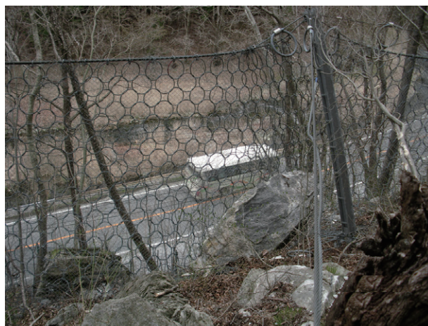
リングネット落石防護柵設置の様子
