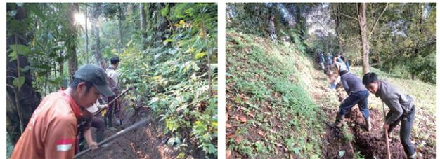
▲送水管埋設のための掘削作業
