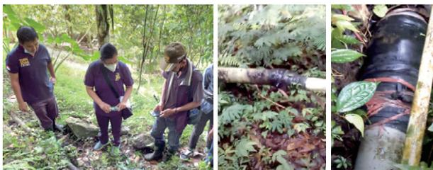
▲漏水箇所の確認（左）とこれまでの配管接続方法（中、右）
