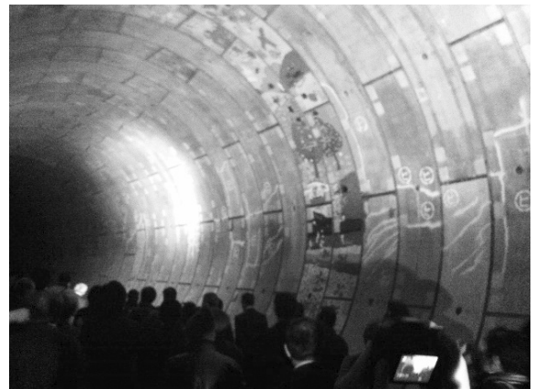
神田川・環状七号線地下調節池
