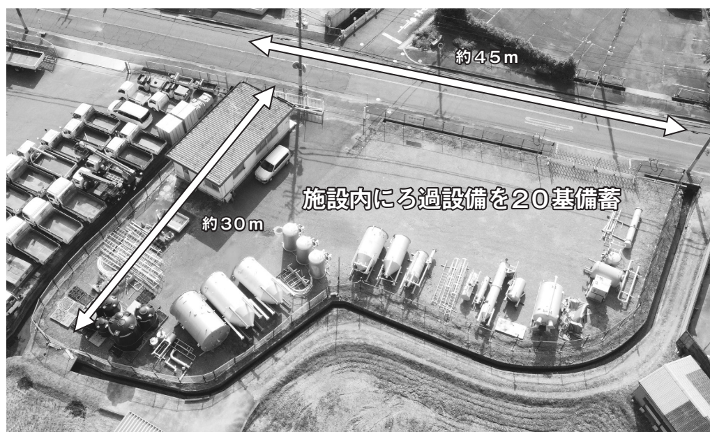
図26 2019年に拡張した資機材の備蓄施設
