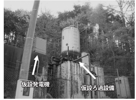
図3 復旧後の様子
