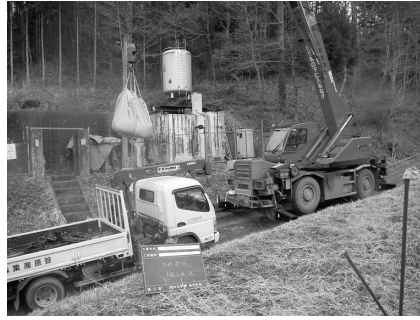
図2 仮設ろ過設備の設置状況
