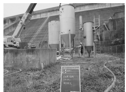
図18 仮設前処理設備の設置状況
