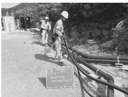
図13 仮設復旧ラインの布設状況
