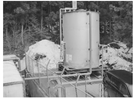
図9 復旧後の様子
