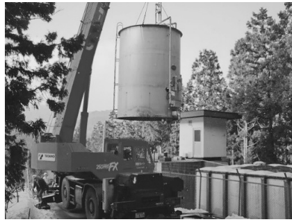
図8 仮設ろ過設備の設置状況
