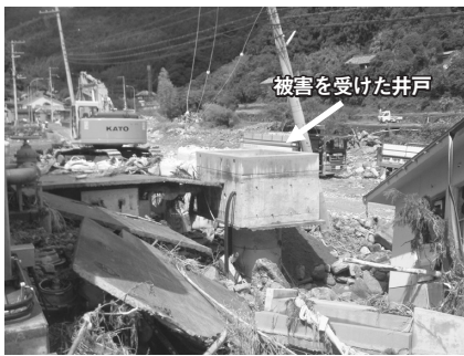
図10 被災後の井戸浄水場内の様子
