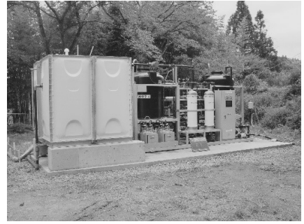
図6 復旧後の様子
