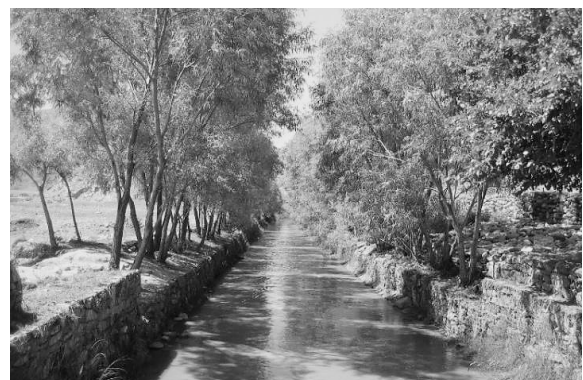
通水後5年後のマルワリード用水路(上図同地点) 用水路両壁は蛇籠工、その背面に柳枝工が施されている (2009年4月)
