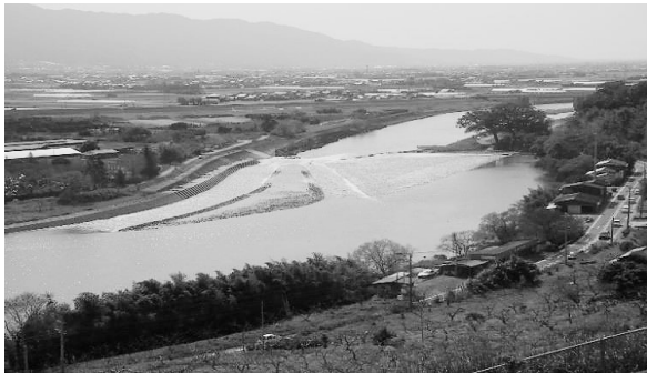
筑後川・斜め堰(山田堰 福岡県朝倉市) 1790年築造
