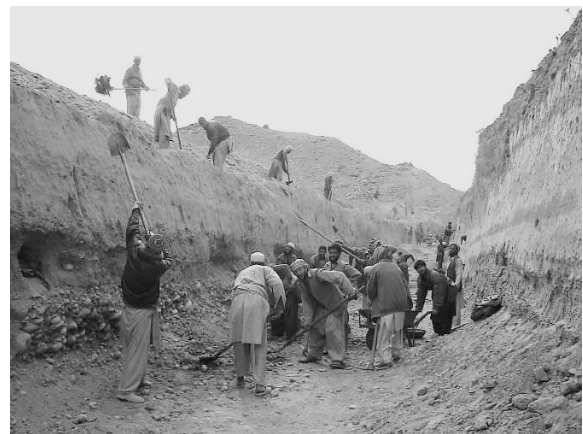
掘削中のマルワリード用水路(2003年12月)
