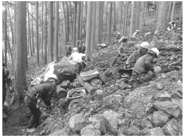
写真10 石積み作業中
