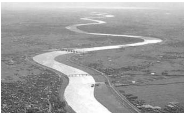
蛇行する筑後川（久留米市上空から有明海方向）
