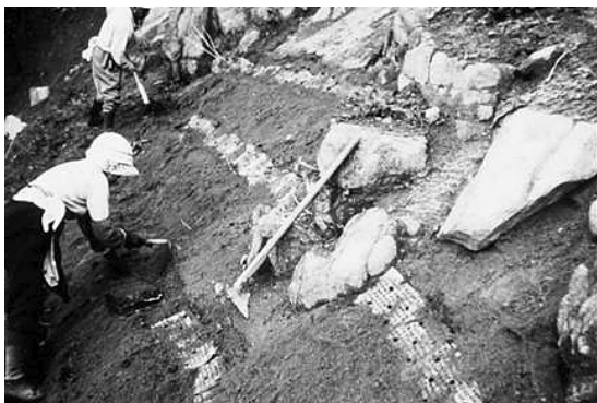
写真3 斜面に植生盤を等高線状に貼り付ける （関東森林管理局：足尾荒廃地の緑化HPより）
