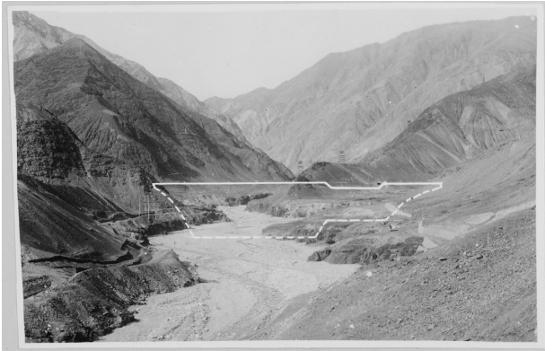
写真7 足尾砂防堰堤工事 (国交省渡良瀬川河川事務所提供～13)
