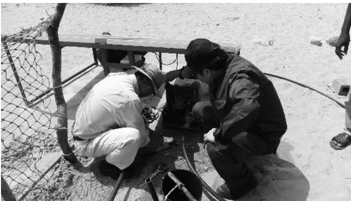
ソーラーポンプシステム設置の様子
