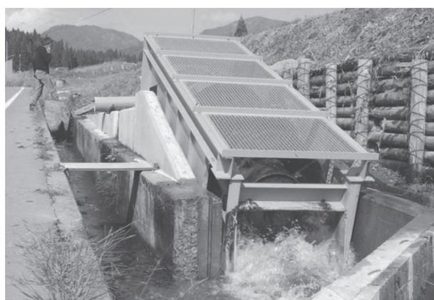
写真1 石徹白に設置された螺旋水車2号機：出力約800W
