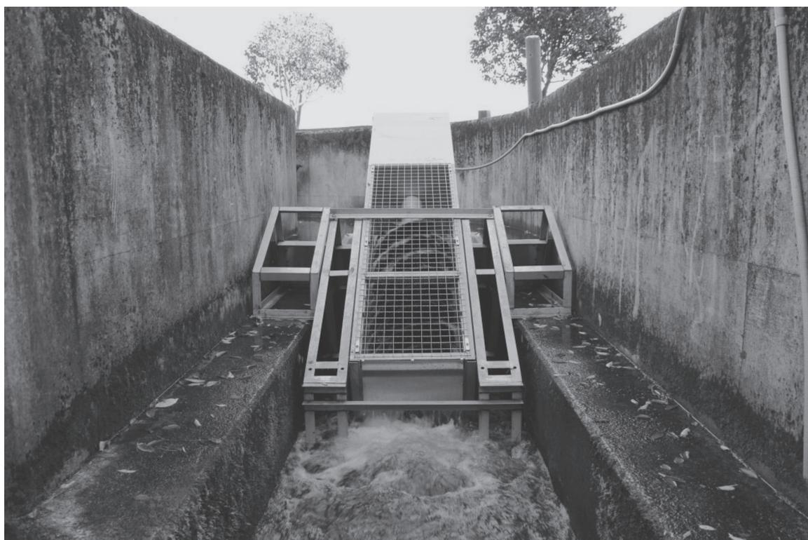
写真3 螺旋式ピコ水力発電装置「ピコピカ500」
