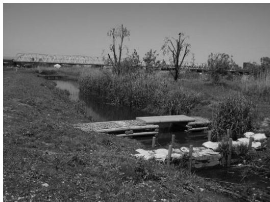
写真2-2 小池の板囲い土嚢堰
