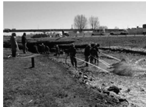
写真4-7 ポンプ・人力での底泥排出
