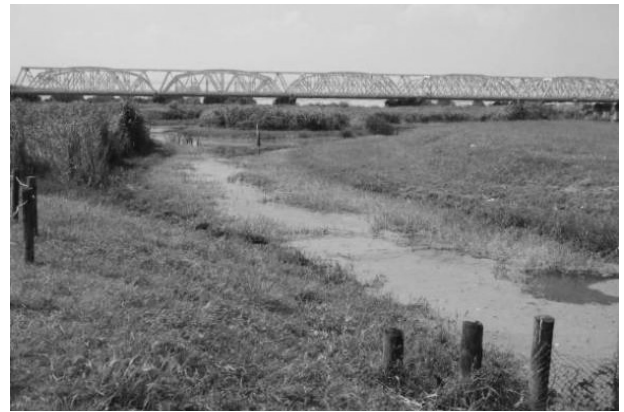
写真4-1 竣工3年目の水辺
