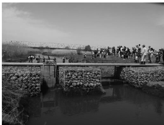
写真2-1 大池の可動堰と板堰（改修後）
