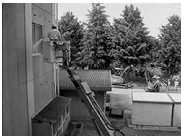
図1 高圧洗浄機での校舎の除染
