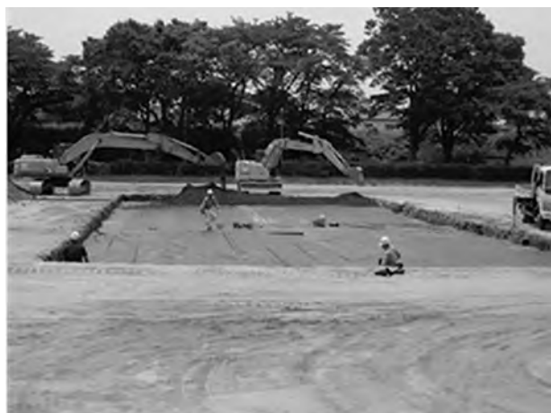
図2 表土を除去し、校庭に埋没させた
