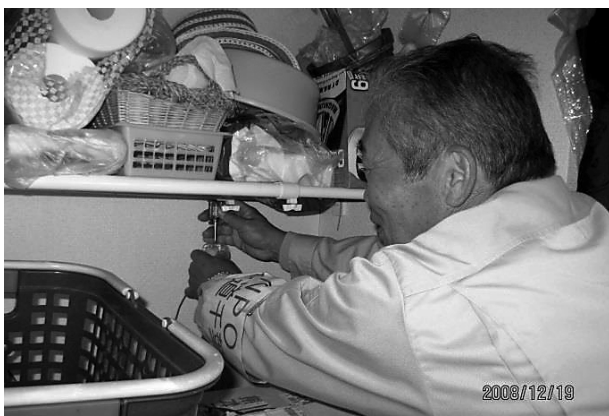
【写真-5】蛇口のパッキン取り替え
