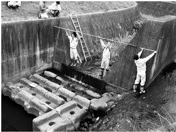
着手前の測量風景 落差工により河川の連続性がない状態でした
