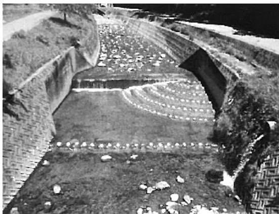
点検結果に基づき、改修した魚道 (岐阜県揖斐郡揖斐川町 飛鳥川)
