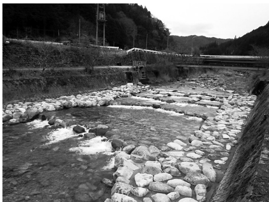
点検結果に基づき、改修した魚道 (岐阜県下呂市 竹原川)
