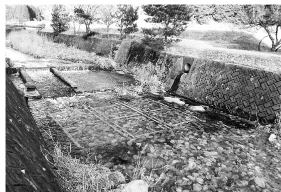
点検結果に基づき、改修した魚道 (岐阜県恵那市 高波川)
