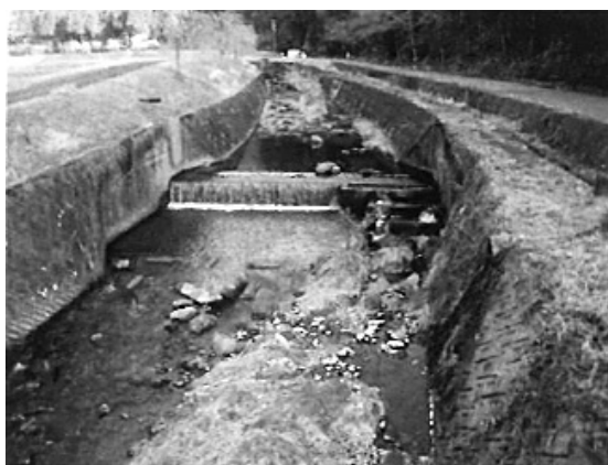
点検結果に基づき、改修した魚道 (岐阜県揖斐郡揖斐川町 飛鳥川)
