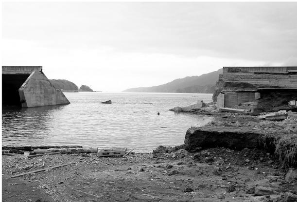
写真 宮古市提供 破壊された防潮堤
