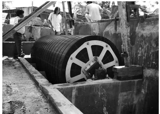
立体格子状接触体を用いた回転円板式排水処理装置
