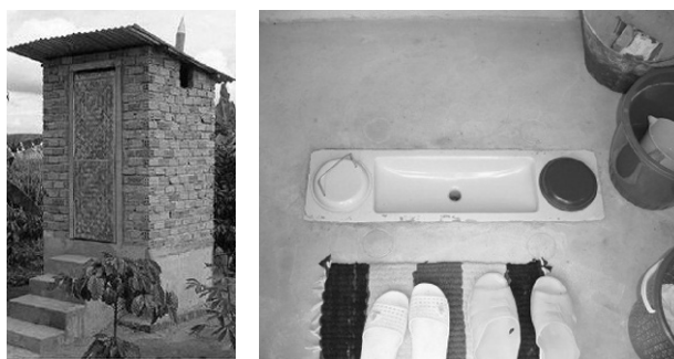
写真3 し尿分離トイレにより灰を用いた大便の処理・農業利用を実現(ベトナム)
