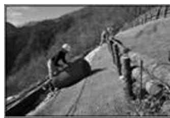
土砂流出防止工
