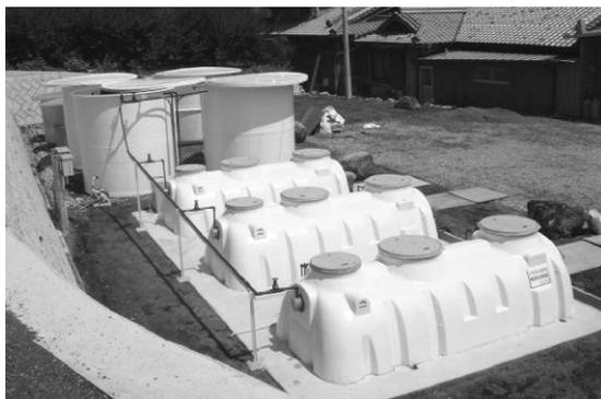
写真-6 ミラクルソル食品加工廃水処理システム
