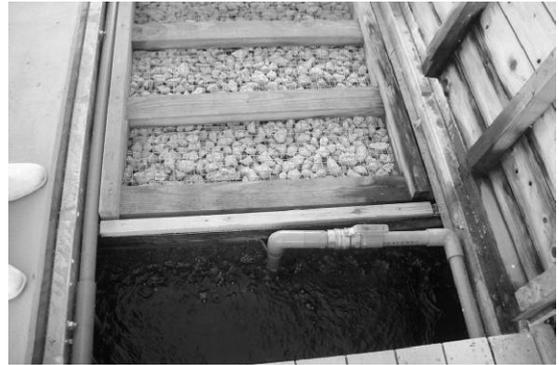
写真-8 ろ過槽内のミラクルソル
