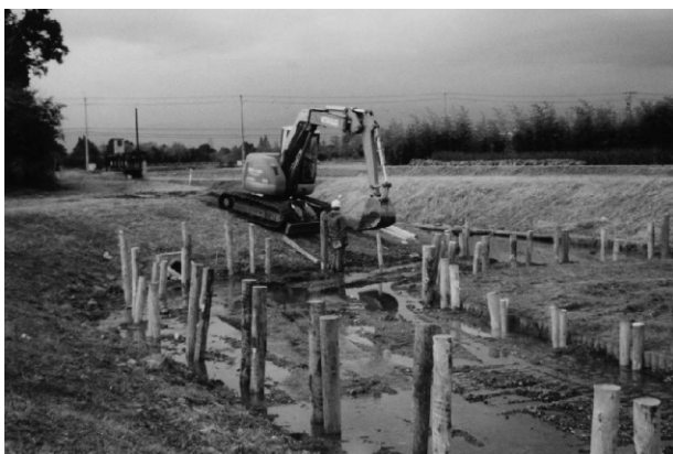
重機を使用する作業
