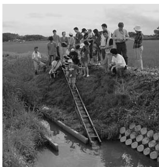
波付き角形U字溝を使用した水田魚道
