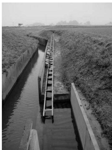
写真-9 加美町排水路法面(1:2.0)設置状況
