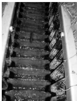
写真-4 遡上状況
