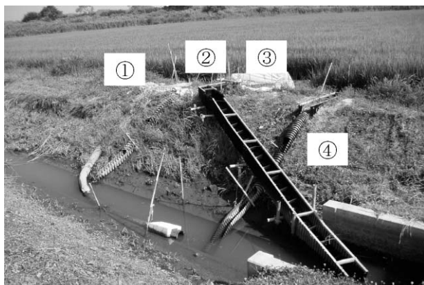
写真-8 伊豆沼3工区排水路法面(1:2.0)設置状況
