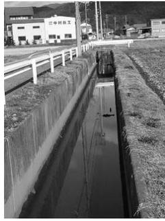
図5 コンクリート化された農業排水路
