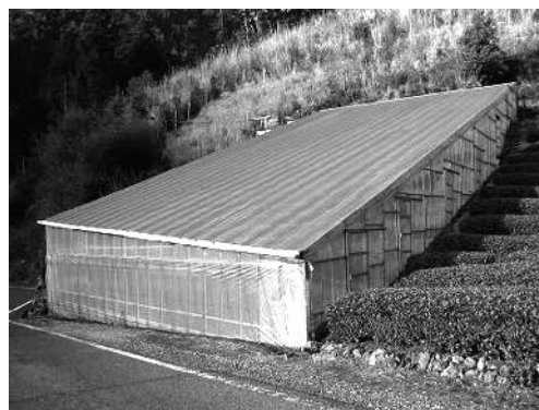
第28図 光触媒塗布を検討している大型温室
