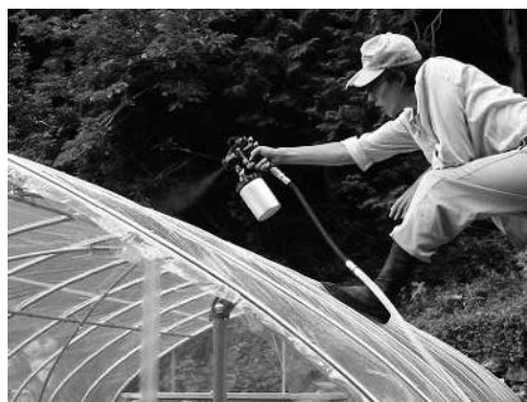
第21図 普及型光触媒温室へのTiO2の塗布
