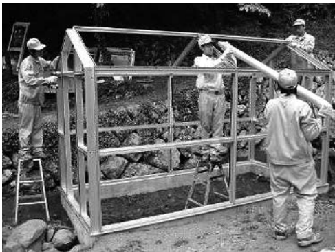
第11図 ガラス温室の組立作業
