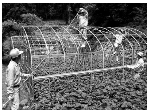
第19図 普及型光触媒温室の組立
