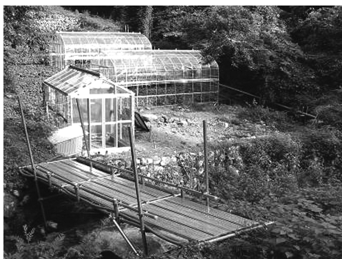
第26図 環境整備を行った温室群周辺
