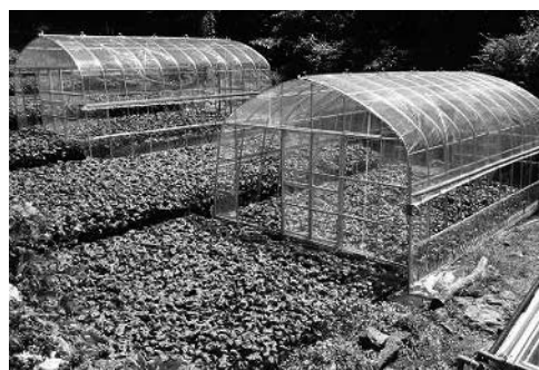
第20図 建設した普及型光触媒温室
