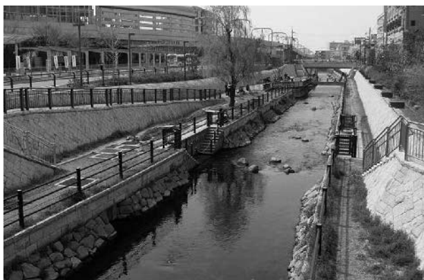
寝屋川駅前整備後。空石積みの護岸で様々な生き物が戻ってきました
