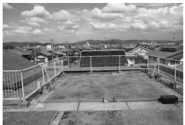
写真1 桂高校の屋上緑化試験圃場
