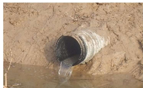
図 17 暗渠排水から排出される塩水
