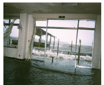
1999年台風第18号による高潮／熊本県水俣港の旅客待合所(国土交通省HP)
