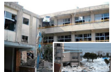
鵜住居小学校 被害状況 （釜石市HP）
