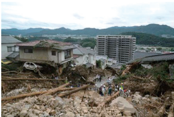
8月 広島市の土砂災害 溪流出口の宅地被害状況（国土技術政策総合研究所 HP）
