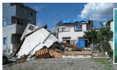
竜巻により倒壊した住宅
