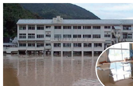
徳島県阿南市那賀川の氾濫状況 加茂地区 加茂谷中学校
