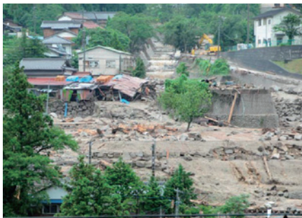
土石流による被災状況(国土交通省HP)
