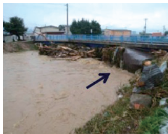
県道吉野橋 流木による河積阻害
