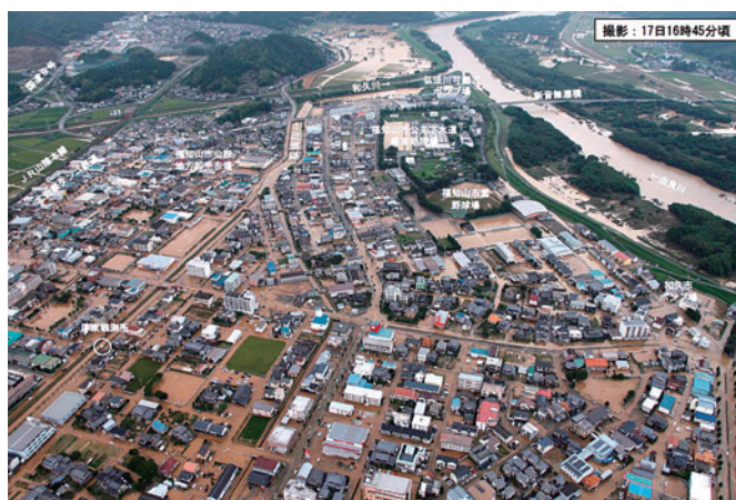
福知山市内の浸水状況（福知山河川国道事務所HP）
