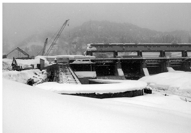
〈写真一7一3〉 宮中発電用取水ダム魚道 雪中工事全景
