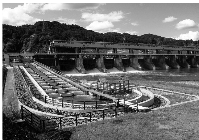
〈写真一7一1〉 宮中発電用取水ダム魚道の全景
