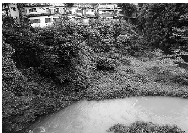
〈写真—3—3〉復旧現場 エコグリーン施工後23年
