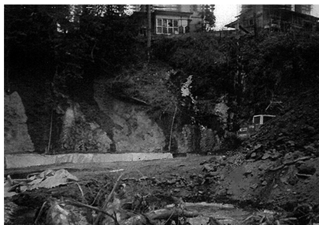
〈写真—3—1〉被災現場 エコグリーン施工前
