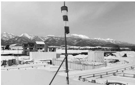
〈写真—8〉 雪寒仮囲い
