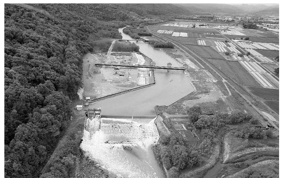
〈写真—7〉空知川頭首工2期工事
