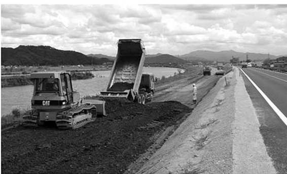
〈写真—5〉一日市地区他築堤工事
