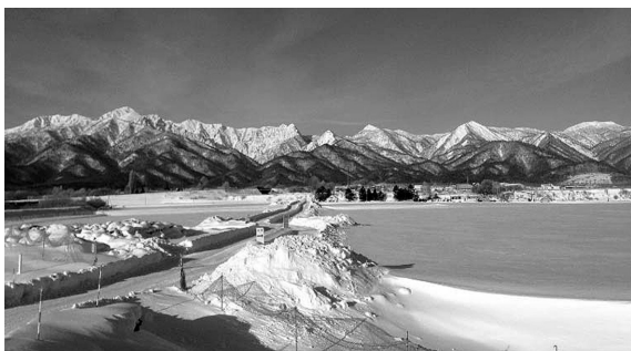
〈写真—10〉 1月の芦別岳と工事用道路
