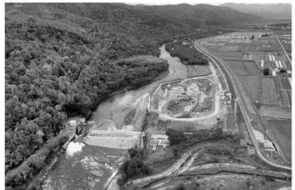
〈写真—6〉空知川頭首工1期工事
