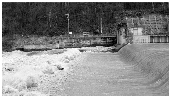
〈写真—12〉 増水時既設固定堰
