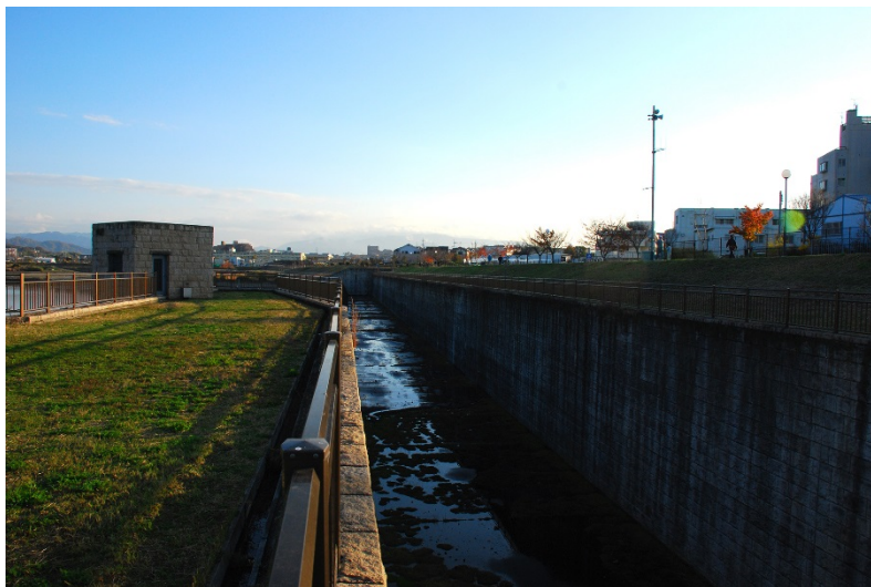
西除非常用洪水吐き
