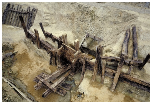
西樋取水部 四番樋
