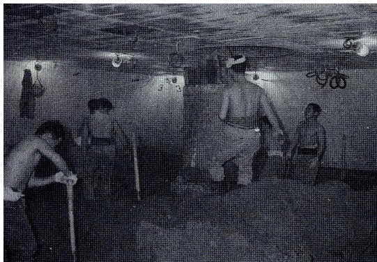
写真5 安治川水門工事状況
