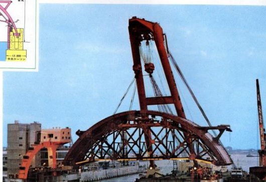
写真8 安治川水門上部工の架設
