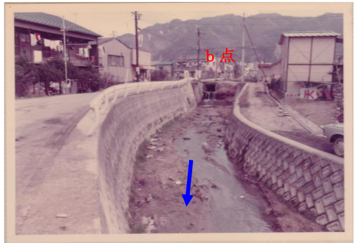
（写真―4）谷田川 b～c 点間（改修済箇所）
