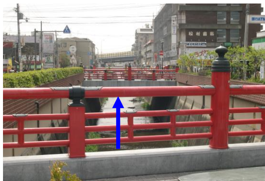
(写真—15) 野崎橋から下流を望む（現在）
