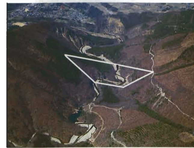
● Kuribaragawa Dam (Dam site)
