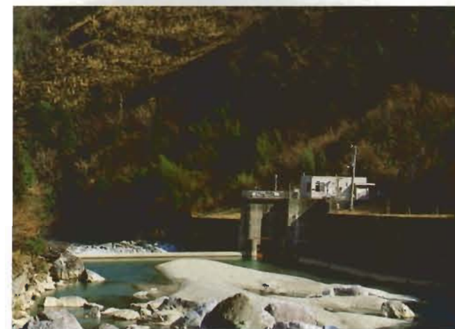
Kochi Canal (Jizojigawa Intake Weir)
