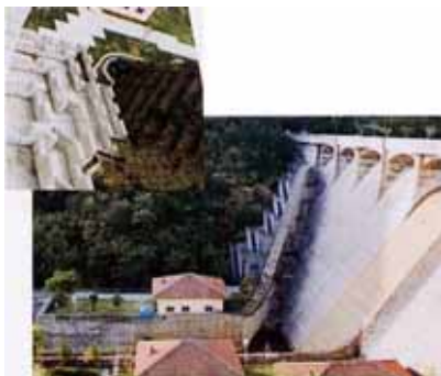
Photo 5 Fishway at Kanna Dam Coupe de la passe à poissons du barrage Kanna
