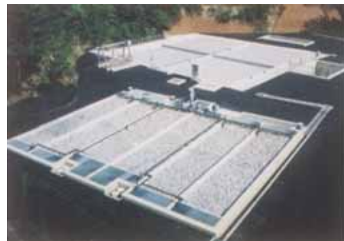
Photo 15 Gravel contact oxidation system with aerator Système d'oxydation avec graviers en contact, muni d'un aérateur
