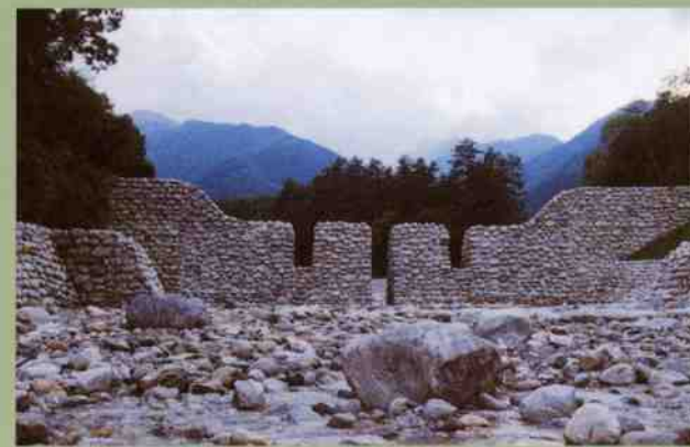
平成15年3月完成 高さ13.5m、長さ92.0mのコンクリートスリットえん堤。 スリット高さ5m×2本、9.5m×1本、スリット幅2.5m、 スリット本数3本。 It was completed in Mar., 2003. It is a slit concrete sabo dam with 13.5 m of the sabo dam height and 92.0 m in length. Slit height : 5 m x 2, 9.5 m x 1, Slit width : 2.5 m, Slit number : 3.
