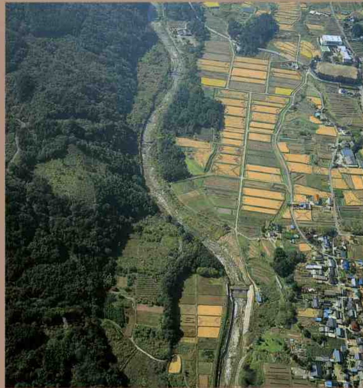
上空から見た尾白川床固群 Sky view of the Ojiragawa Groundsills
