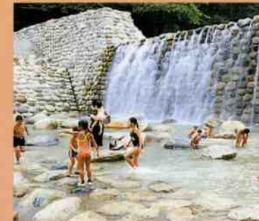
水叩プール Pool at the front apron
