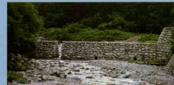
平成12年5月改修。 スリット高さ5m、スリット幅2m、スリット本数1本。 It was repaired in May., 2000. Slit height:5m, Slit width:2m, Slit number:1.
